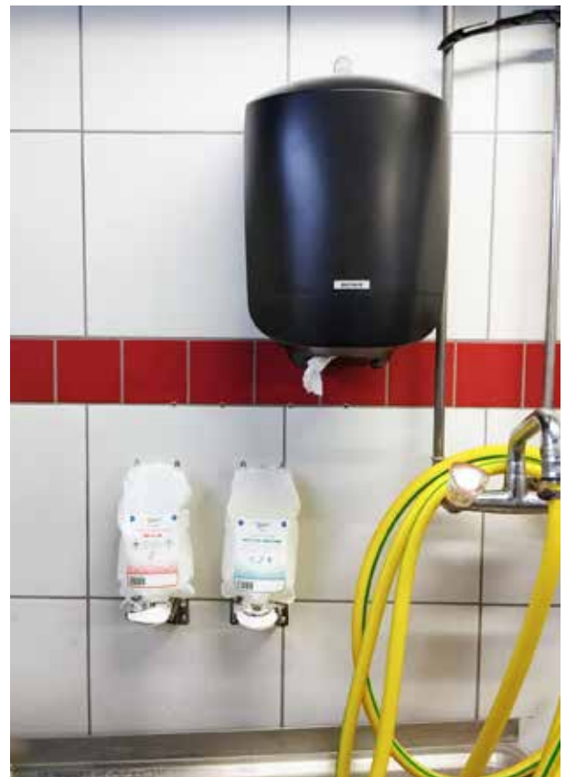
Nach der Montage
